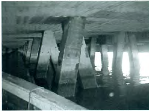
Figura 2. Disposición de pilotes.
