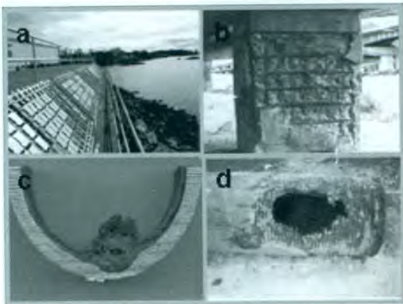
Cuatro de los ambientes en los que se presenta deterioro de materiales: a) atmósfera, b) concreto reforzado, c) microorganismos, d) suelo y agua.
