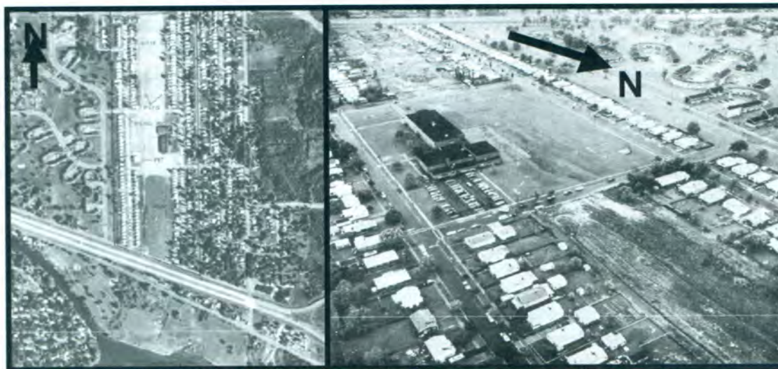
Figura 2. Fotografías de la zona afectada. Canal Love (6, 7).
