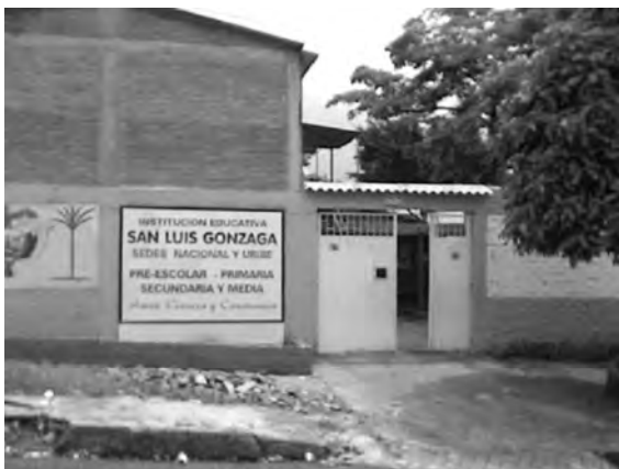
Foto 1. Entrada principal del colegio San Luis Gonzaga.
