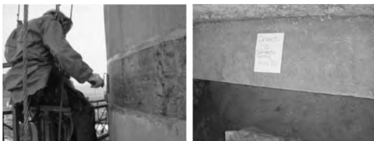
a) Reforzamiento con fibras de carbono Edificio Ultramar, Medellín.
