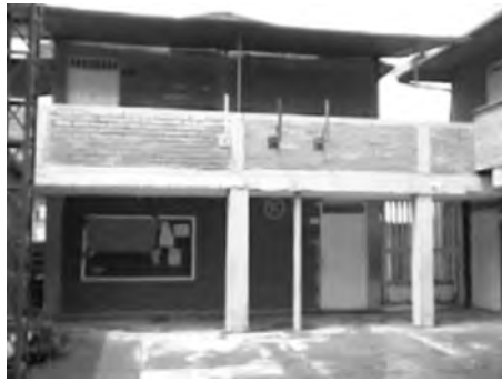
a) Zona 5: estructura en pórticos de concreto reforzado.
