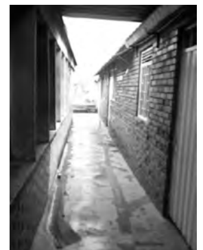
f) Pasillo entre las zonas 3 y 4.
