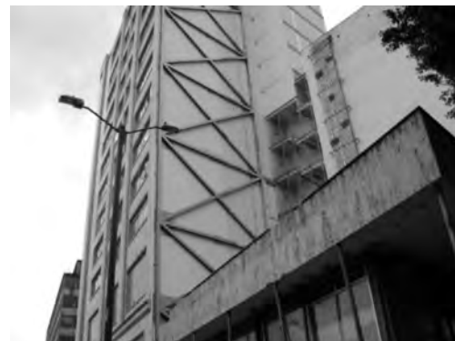
a) Sistema de diagonales metálicas.
