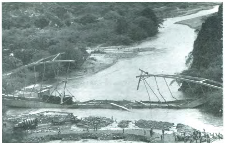
Colapso del Puente Pescadero, enero 9 de 1996.
