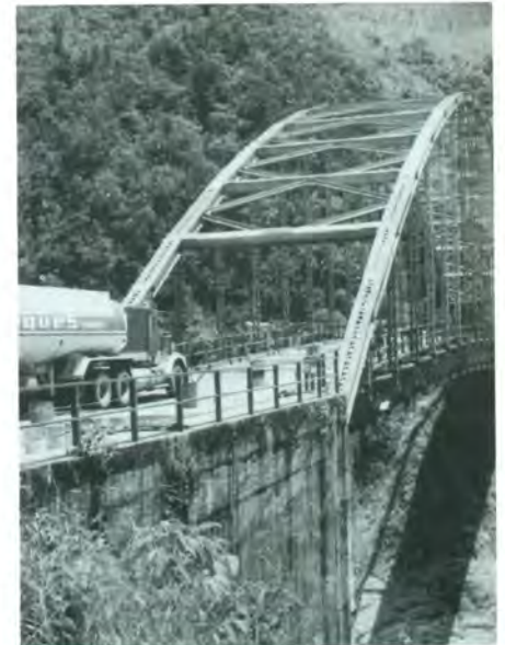
Puente Quebrada Blanca, Vía Bogotá/Villavicencio.
