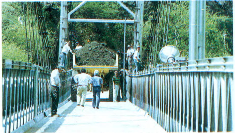
Prueba de carga a la culminación del puente provisional a cargo de los funcionarios de la oficina de emergencias. Febrero 15/96.
