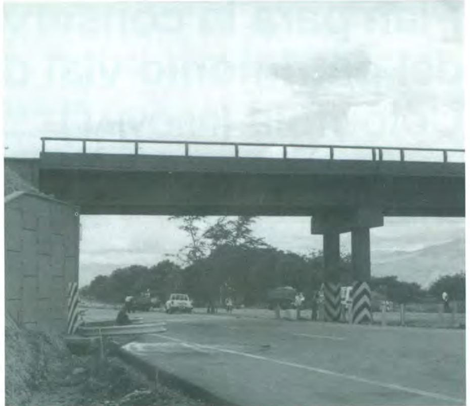
Puente sobre la vía Buga/Tuluá.
