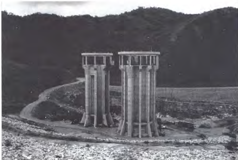
Torres de captación central hidroeléctrica de San Carlos.
