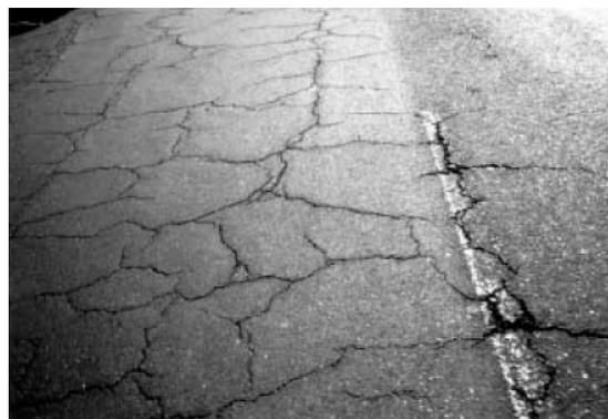
Figura 1. Agrietamiento tipo piel de cocodrilo.
