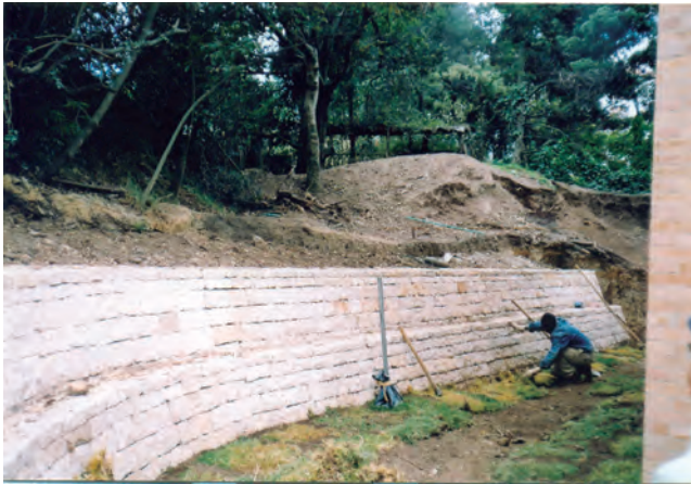
Fotografía 9. Muro posterior durante la construcción.
