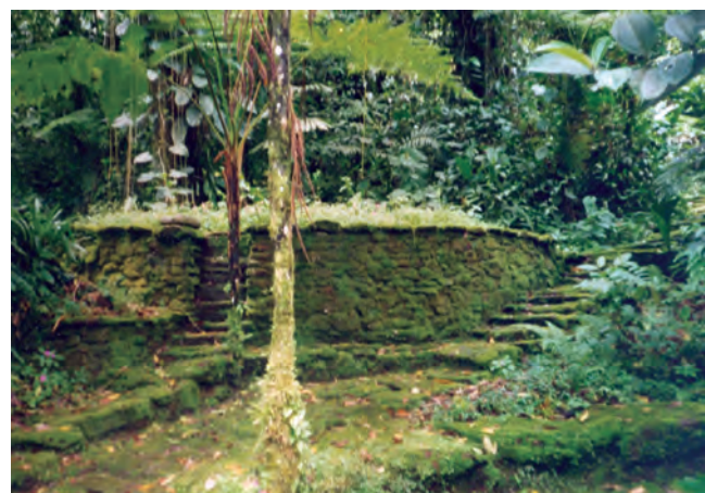
Fotografía 3. Muro de cara vertical.
