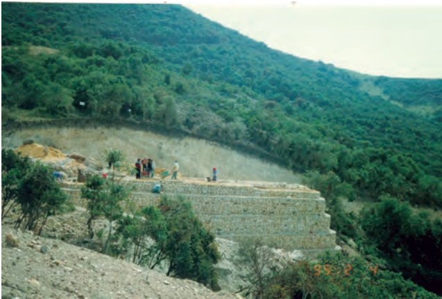
Fotografía 4. Muro de más de 6,0 m de altura, durante la construcción.
