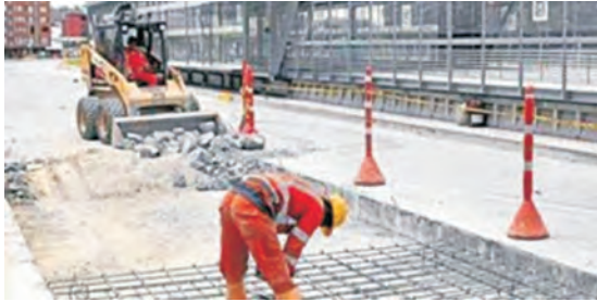
Transmilenio. Reconstrucción permanente del pavimento rígido.
