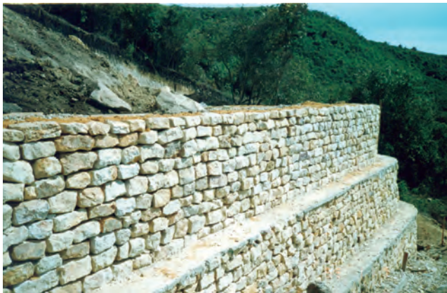
Fotografía 5. Detalle de un muro.
