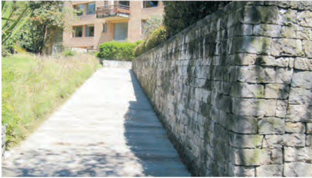
Fotografía 7. Estado actual muro principal.
