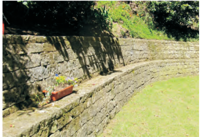
Fotografía 10. Estado actual del muro posterior.
