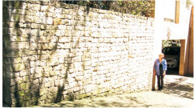
Fotografía 8. Zona de máxima altura de muros.
