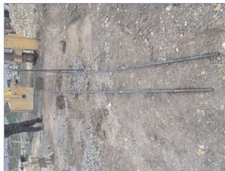
**Figura 7.** Proceso constructivo de una pila de agregado compactado. Nótese el elemento de refuerzo para su desempeño a tensión.
