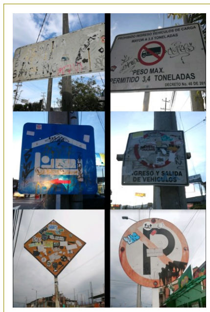
Figura 2. Señales en estados regular y malo.
