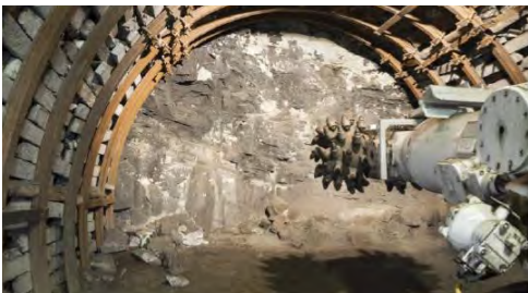
Ilustración 3. Sistema de perforación con rozadora. Fuente: www.structuralia.com .
