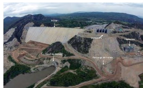
Fotografía 10. Represa CFRD y obras en el estribo derecho CHEQ.
