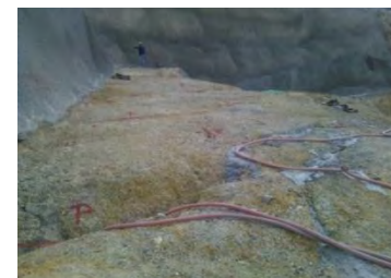
Fotografía 6. Cizallas tratadas con inyecciones desde superficie.
