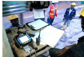
Fotografía 8. Inspector revisando los procedimientos de inyección.
