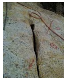
Fotografía 6. Cizallas tratadas con inyecciones desde superficie.
