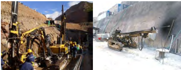
Fotografía 4. Perforadoras de rotación y rotopercusión. Fuente: Los autores.
