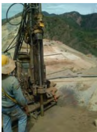
Fotografía 1. Perforación exploratoria. Fuente: Los autores.
