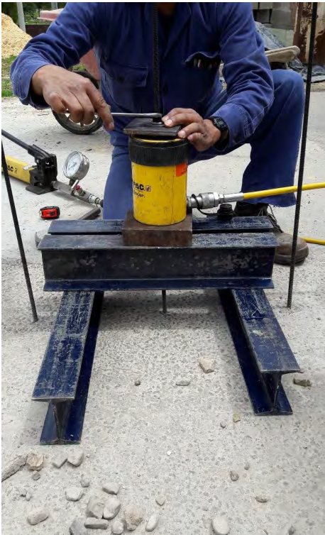
Figura 1. Montaje final para ensayos no confinados a tensión.
