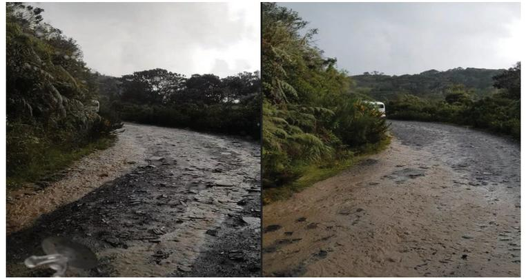
**Figura 18.** Imágenes de surcos longitudinales y lodazales durante lluvias intensas.
