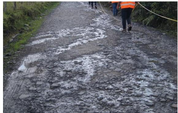
**Figura 10.** Condición de las cunetas y surcos longitudinales en el tramo 2.
