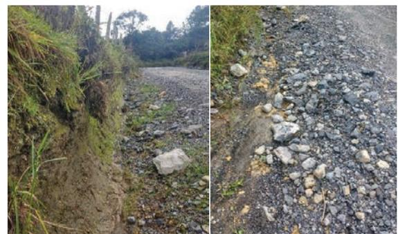
**Figura 12.** Condición de las cunetas en el tramo 2.
