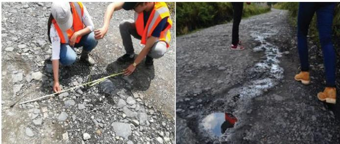
**Figura 8.** Ondulaciones, baches y surcos longitudinales en el tramo 2.
