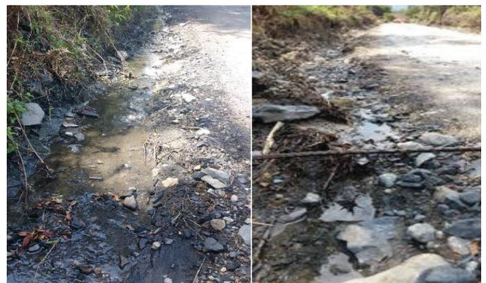
**Figura 6.** Condición de las cunetas en el tramo 1.
