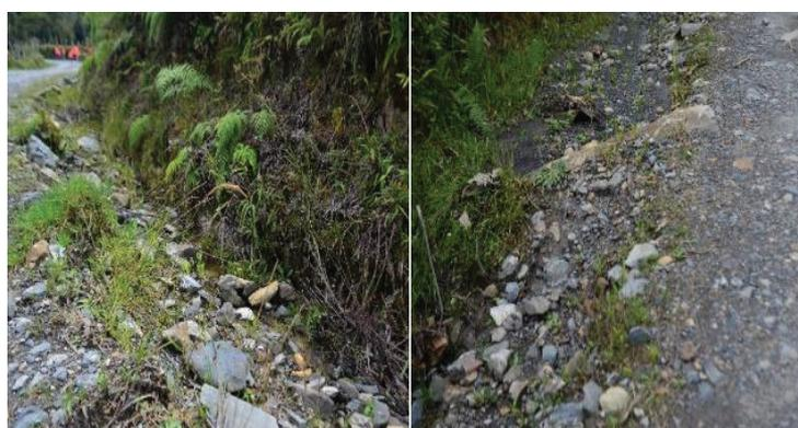
**Figura 15.** Imágenes de cunetas erosionadas y obstruidas en el tramo 3.
