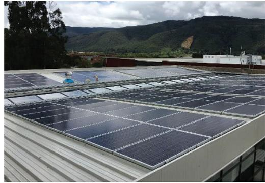
**Fotografía 6.** Paneles solares sobre la cubierta del edificio.
