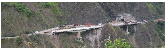
Figura 1. Localización del portal de entrada túnel 11. Ruta 40 Cisneros - Loboguerrero.
