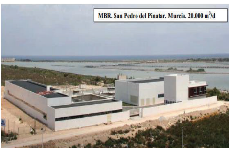
Figura 5. Vista general de la planta San Pedro del Pinatar (España).
