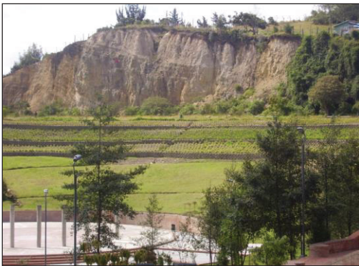
Fotografía 1. Talud norte del parque Mirador de los Nevados.
