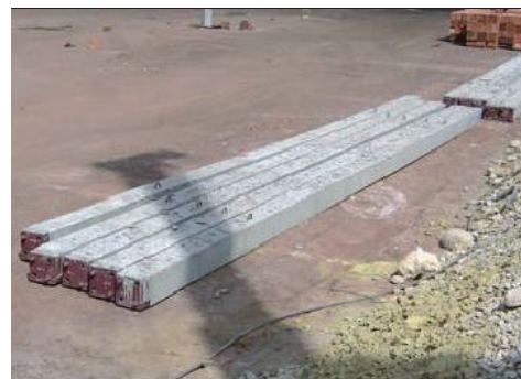
Figura 2. Pilotes prefabricados y juntas en los extremos.
