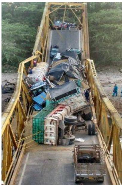
**Figura 2.** Un ejemplo del efecto de las sobrecargas sobre la infraestructura vial nacional<sup>28</sup>.
