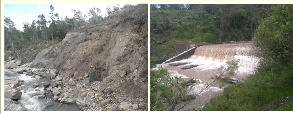
**Figura 2.** Izquierda: Procesos de socavación y erosión en el río Cáqueza. Derecha: Diques en concreto ciclópeo tipo azud de cuatro metros de altura a nivel de vertedero, con los cuales se ha logrado el control local de dichos procesos (Hidroconsulta, 2018).
