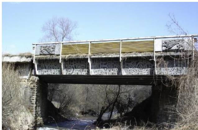
Figura 1. Puente compuesto Ginzi Highway, en Bulgaria (tomada de Blaga et al., 2015).
