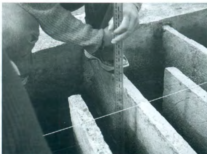
Figura 5. Medición de profundidad de lámina de agua.
