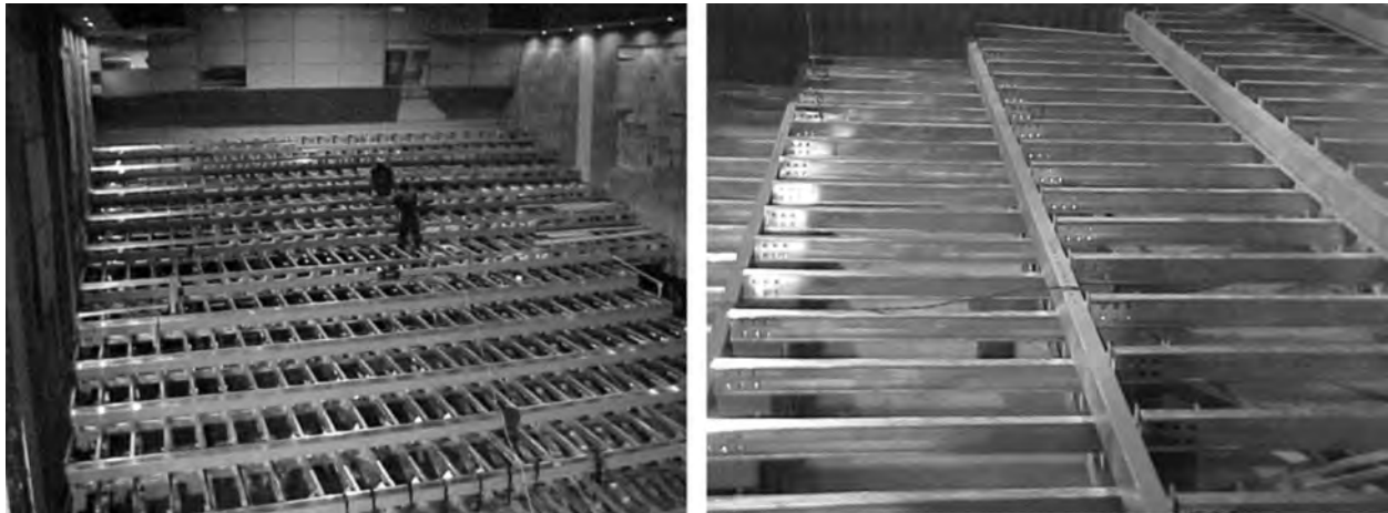
Figura 3. Adecuación de cines en el Centro Andino, Bogotá (fotos cortesía de Ingeniería Óptima Ltda.).
