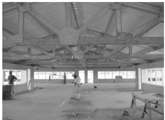
Figura 5. Cerchas de cubierta en alojamiento militar (foto cortesía de Ingeniería Óptima Ltda.).
