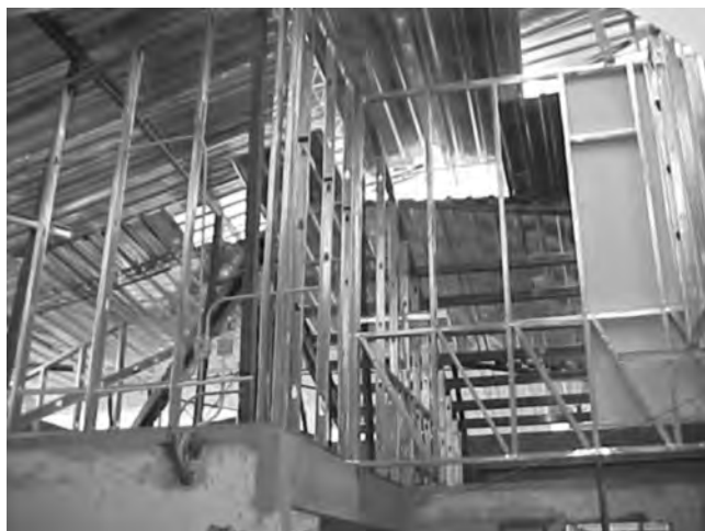
Figura 8. Rehabilitación del convento de Santo Domingo en Bogotá (foto cortesía de Ingeniería Óptima Ltda.).
