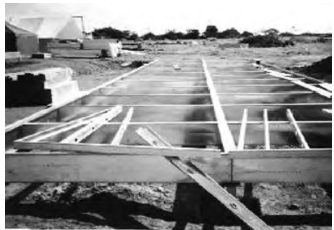
Figura 4. Entresijo para alojamiento militar (foto cortesía de Ingeniería Óptima Ltda.).
