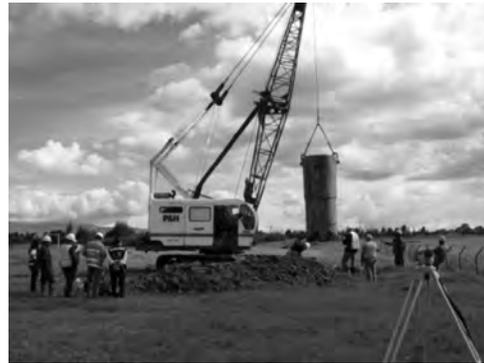
**Foto 1.** Masa utilizada en las pruebas sobre los pilotes preexcavados. Masa de 14 ton con altura de caída variable.
