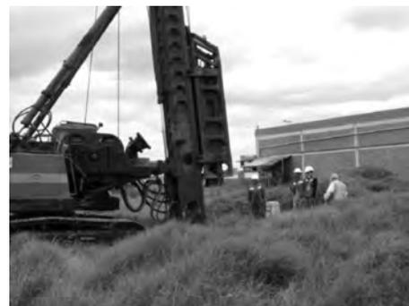
**Foto 2.** Masa utilizada en las pruebas sobre los pilotes hincados. Masa de 6 ton de peso con una altura de caída de 0,80 m.
