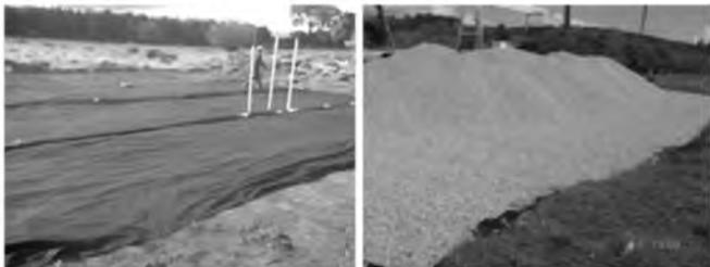
Foto 9. Cobertura con geotextil. Foto 10. Cargas con material granular.
