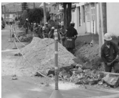
Dependiendo de la estabilidad del suelo, es necesario proteger las excavaciones con formaletas para evitar erosión o derrumbe de los taludes. Las superficies expuestas por las excavaciones deben soportarse y protegerse hasta la terminación de la obra. Dicha protección se debe hacer con empradización, mampostería en piedra, etc.
