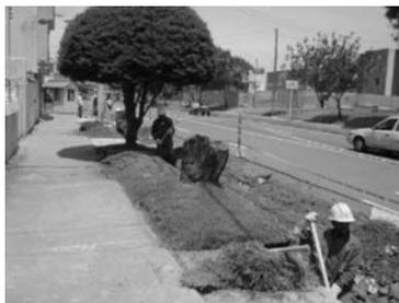
El despeje es el retiro de toda la vegetación u otro material no deseable hasta el nivel del terreno natural, de manera que la superficie quede despejada. Incluye la tala y eventual corte de árboles y arbustos, el corte de maleza y la remoción, transporte y disposición de todos los residuos respectivos. Para este efecto, se deben seguir las especificaciones contenidas en la ficha sobre despeje y corte de vegetación.
