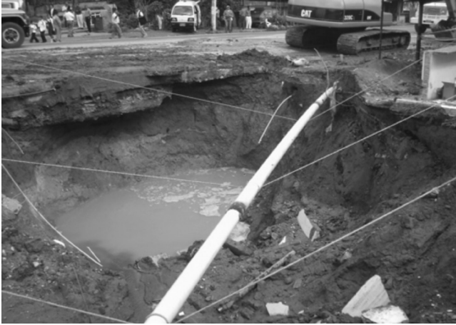
Figura 1. Colapso de tramo de alcantarillado con exposición de contaminación a cielo abierto.
