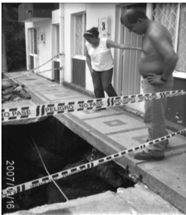
Figura 3. Afectación de propiedad privada por colapso de alcantarillado en la ciudad de Ibagué (2007).
