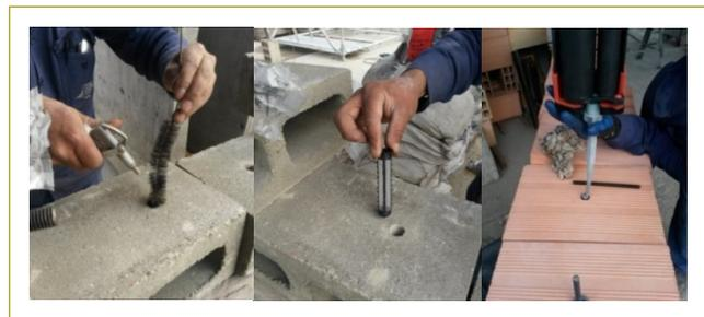
**Figura 4.** Limpieza e instalación de los anclajes.
